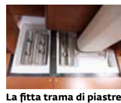
La fitta trama di piastre a "C" per i prigionieri che insistono sulla contropiastra annegata
