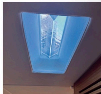
Mehrere Prismen im Deck bringen erstaunlich viel Tageslicht in die Innenräume.
